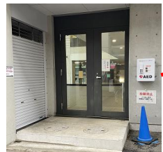
大学ユリの木ホール 体育館側外壁 (ユリの木 事務室 内6841)
