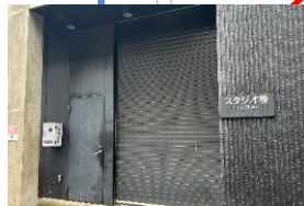
大学スタジオ棟 9号館側外壁
