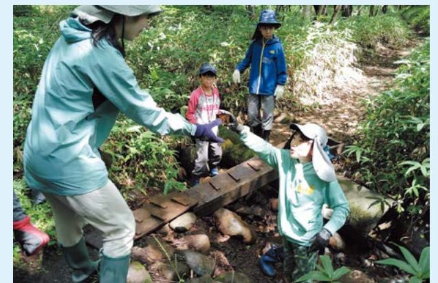
清里の森の中で自然歩道の修復中
