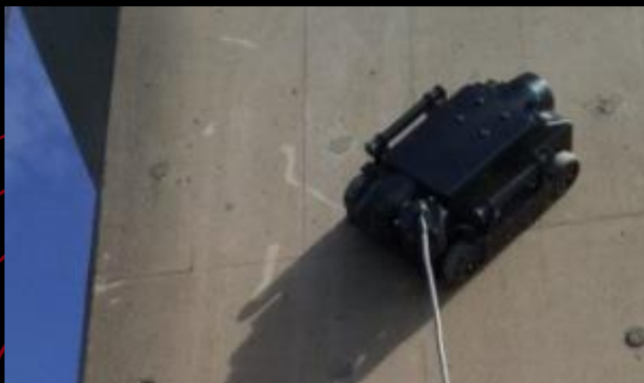
壁面・天井の吸着走行によるインフラ点検
